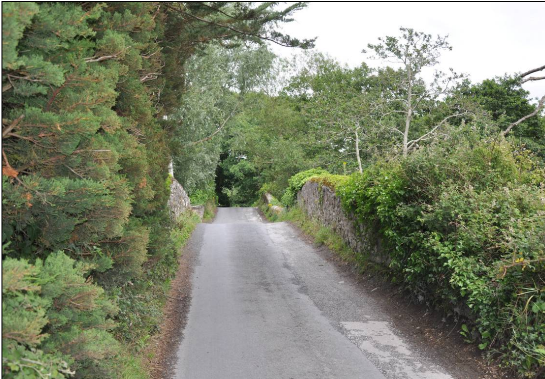
Photo 3.4.6 –Existing Gilloge Bridge
