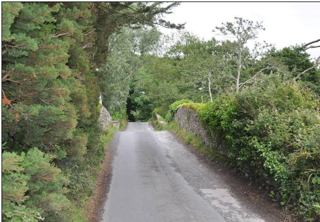
Photo 4.6 –Existing Gilloge Bridge
